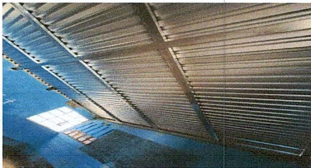
Foto 3: Sustitucion de techo.
