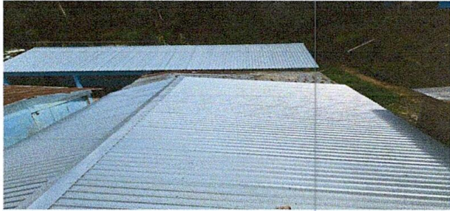
Foto1: Sustitucion de techo.
