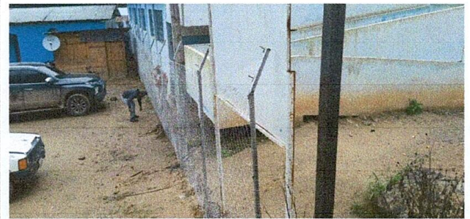
Foto 4: Sustitucion de malla.
